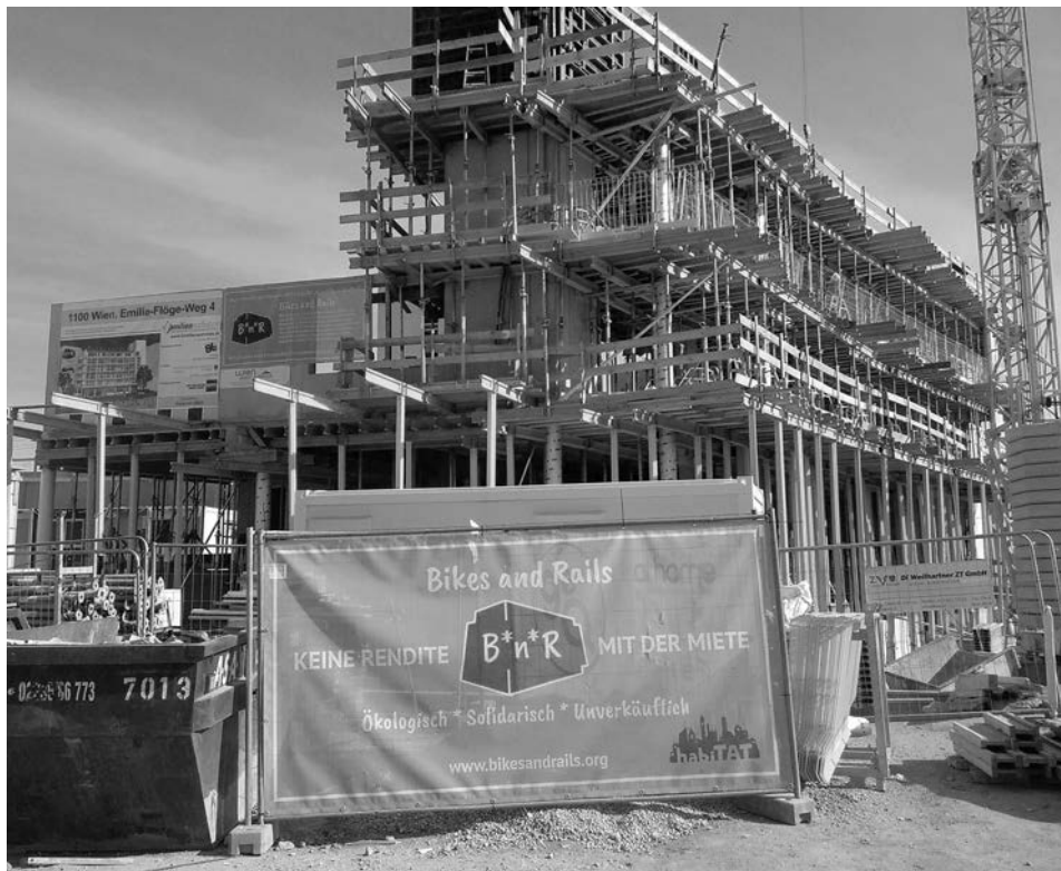
Die Baustelle des Hausprojekts Bikes and Rails im Wiener Sonnwendviertel, März 2019. Foto – dérive .
